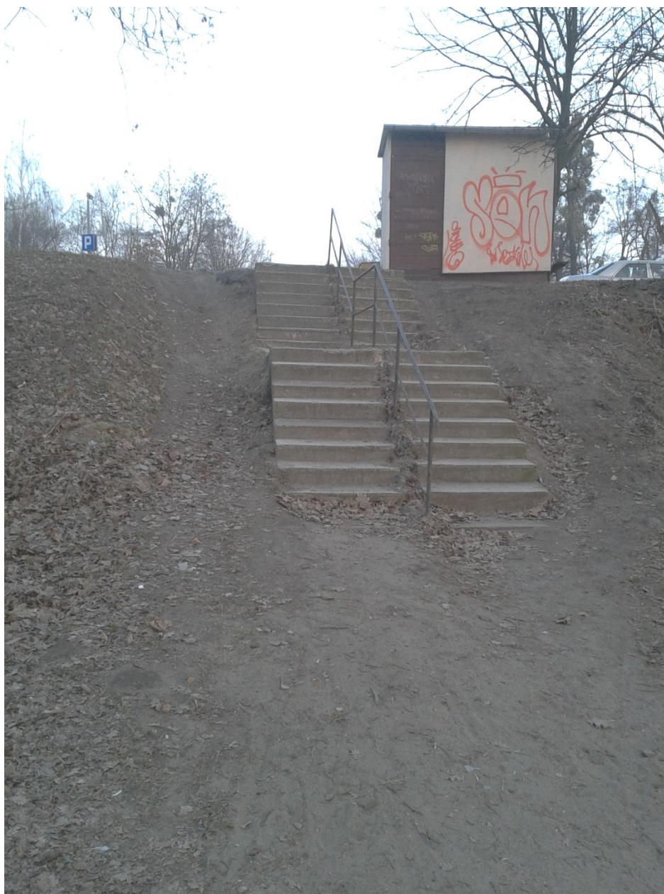
Istniejące schody prowadzące do parku od strony PKP przeznaczone do remontu
